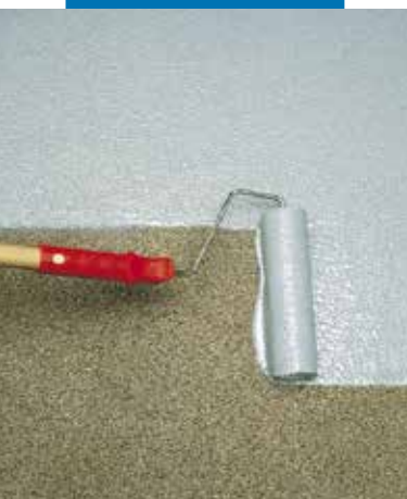
Aplikacja Mapecoat I 24 za pomocą wałka
