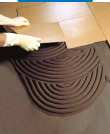
Montaż płytek gresowych na warstwie hydroizolacji Mapelastic
