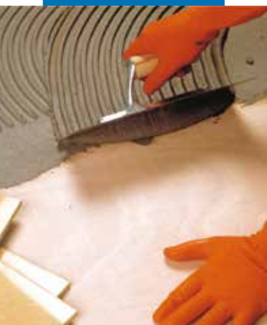
Montaż płytek gresowych z użyciem zaprawy klejącej Elastorapid na sklejkę wodoodporną
