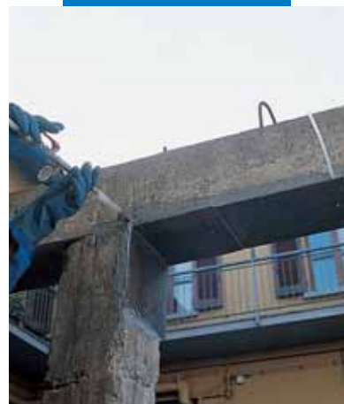
Naprawa belki przez iniekcję preparatem Epojet
