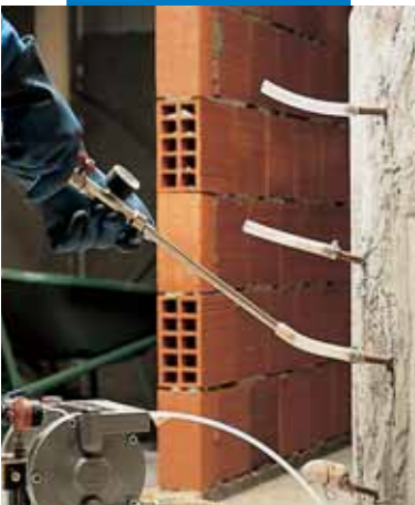
Iniekcja preparatu Epojet w zarysowanym pilastrze
