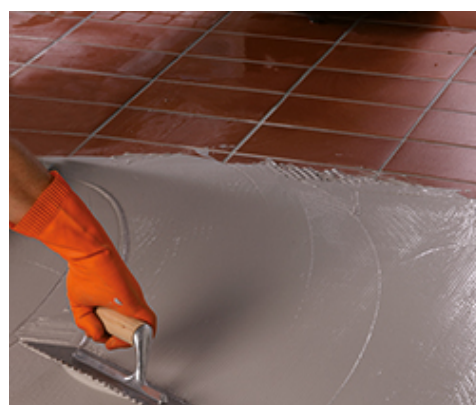
Nakładanie drugiej warstwy Monolastic na Mapenet 150
