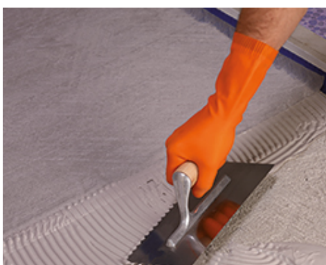
Nakładanie pierwszej warstwy Monolastic na Mapetex Sel N na nowym jastrychu
