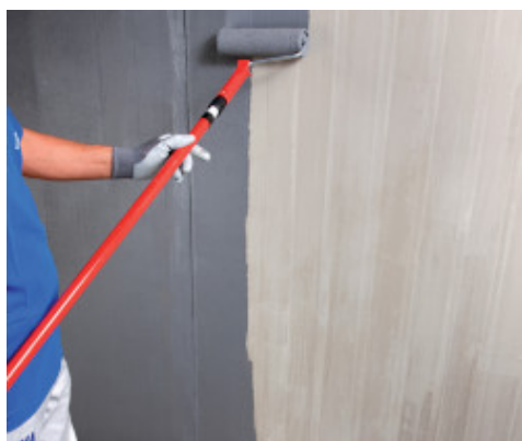
Nakładanie Eco Prim Grip Plus wałkiem na powierzchnię betonową
