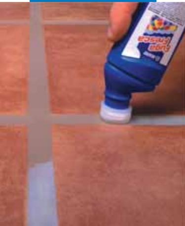
Zastosowanie Fuga Fresca na posadzce ceramicznej
