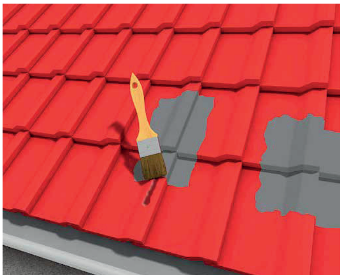
1 Uszczelnienie i naprawa dachówek
