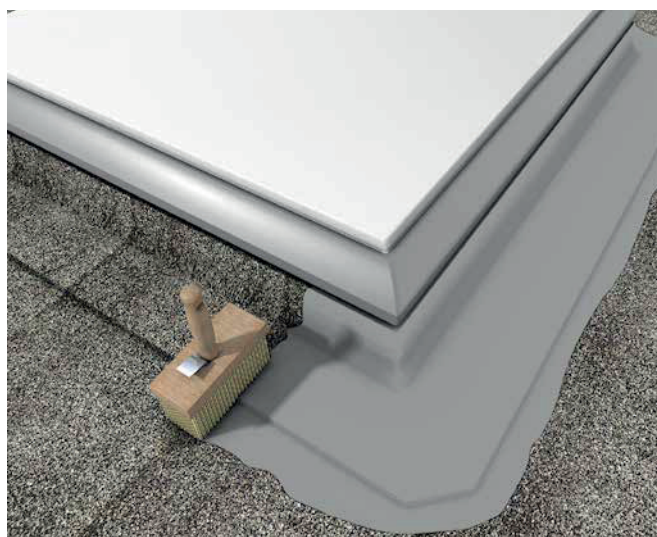
4 Uszczelnienie przejść i połączeń w obszarze dachu
