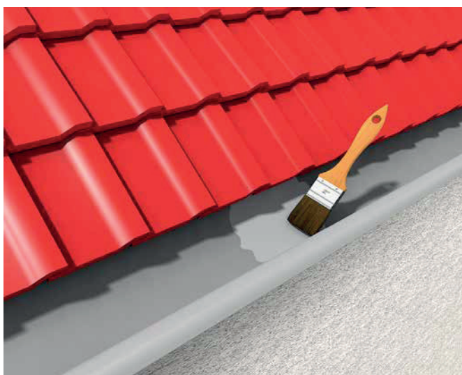
3 Uszczelnienie i naprawa rynien
